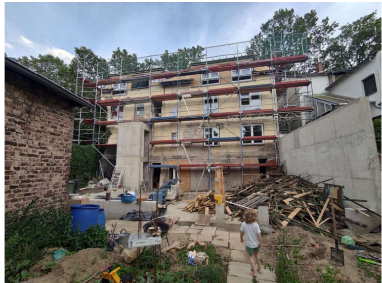
Es ist noch viel zu tun auf der Baustelle
